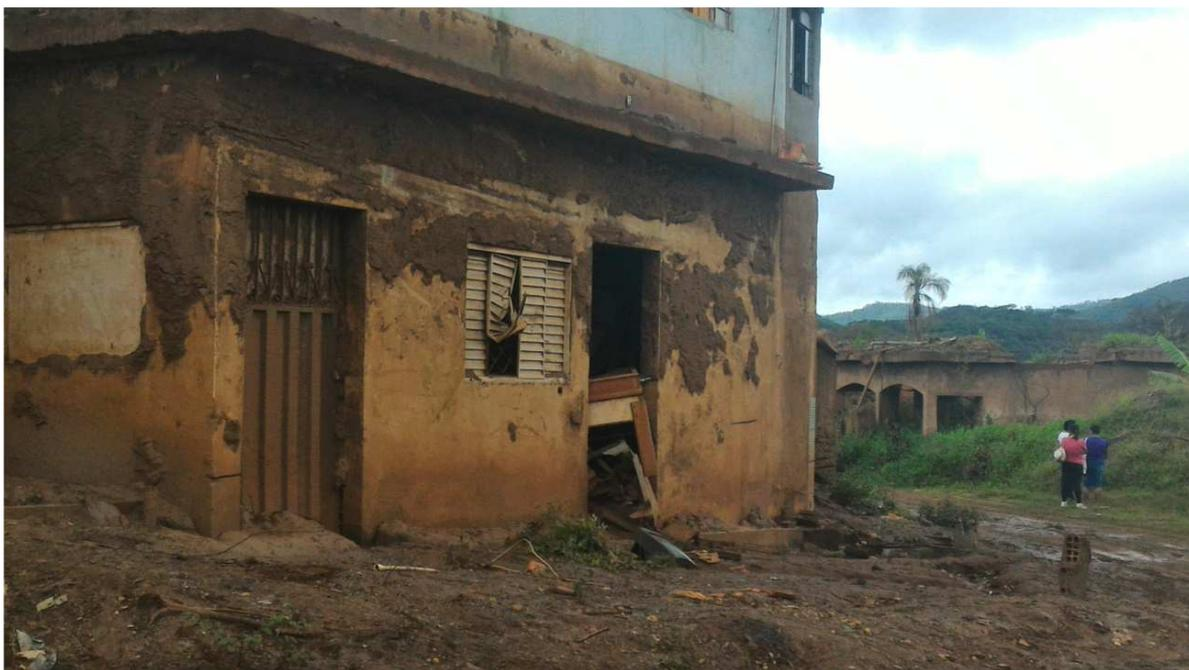
Figura 8 – Altura atingida pela lama ao soterrar as casas em Bento Rodrigues.
